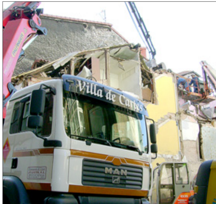
Imagen del derribo del edificio número 16.
